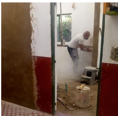
Die Wand wird eingerissen
